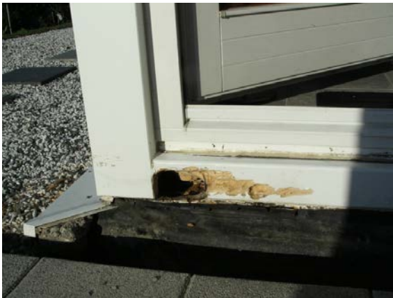
Kundenfotos: Massivholzrestauration mit SR5550; links: verrottetes Holz vor der Reparatur, rechts: nach der Reparatur und vor Beschichtung mittels Grundierung und Lack
