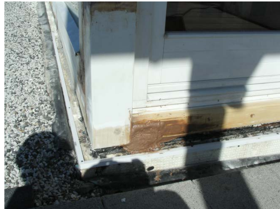
Kundenfotos: Massivholzrestauration mit SR5550; links: verrottetes Holz vor der Reparatur, rechts: nach der Reparatur und vor Beschichtung mittels Grundierung und Lack
